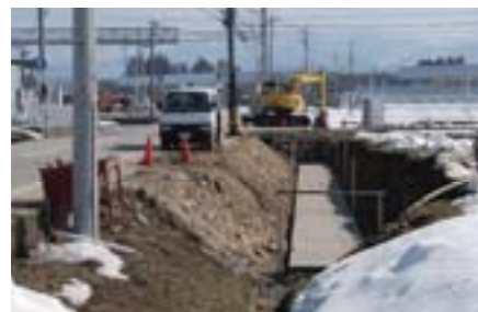
県道の拡幅 (北野地内)
