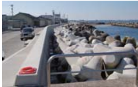
海岸保全工事 (常盤町地内)
