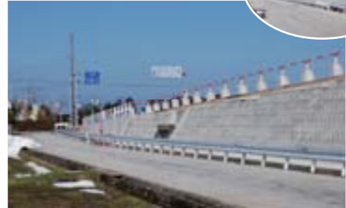
陸橋歩道の設置 (辰野地内)
