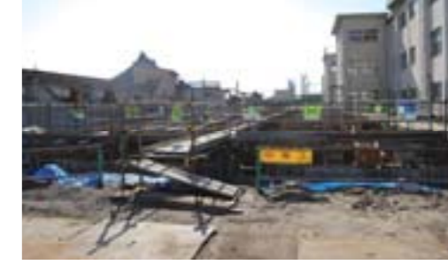
滑川高校海洋科実習棟建設
