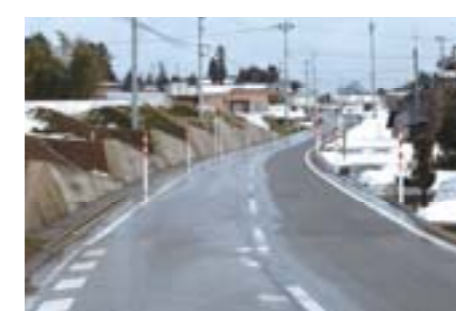
道路改良(開地内)
